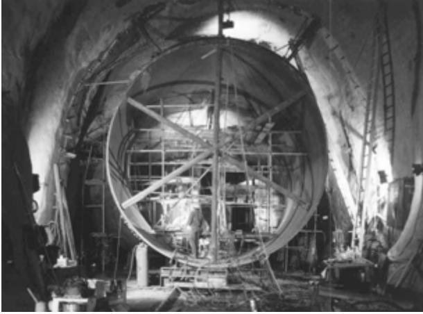
Abb. 5 Montage Stollenpanzerung
